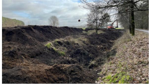
Der Erdaushub früherer Instandsetzungsmaßnahmen wird abgetragen und der am Rande der Fläche befindliche Graben mit dem Boden verfüllt
