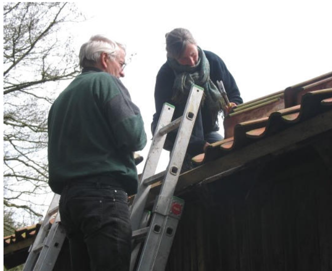
Franz Berger, Heike Vullmer & Hans-Jürgen Maaß (am Fotoapparat) bei der aufwendigen Dachreparatur an der NABU-Scheune. Nun bleibt bei Regen alles trocken!
