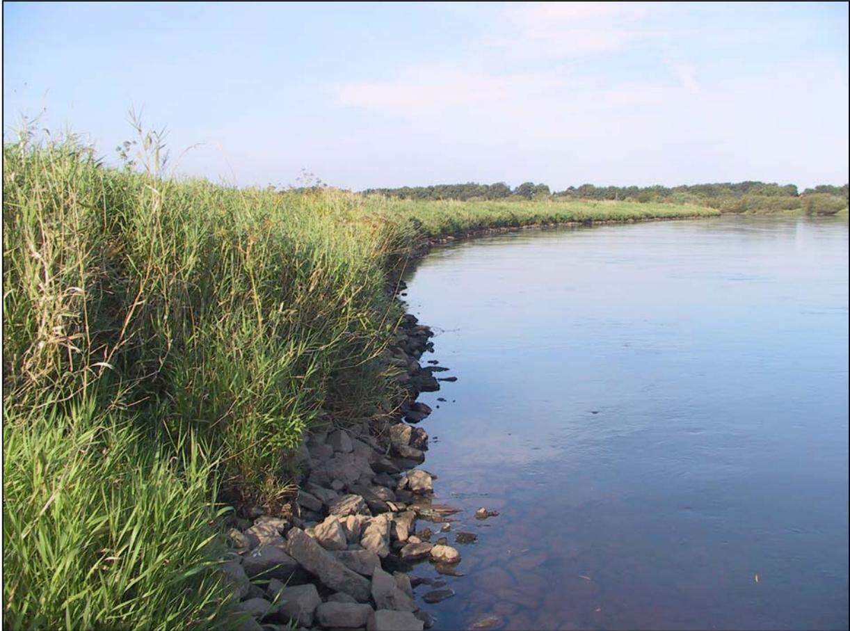
Abb. 7-1: Befestigte Außenkurve bei Westen
